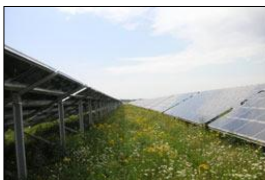
Abb. 12: Beispiel „Aufgeständertes Modulfeld“
