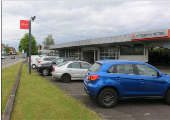
Abb. 2: Südansicht von Turmstraße
