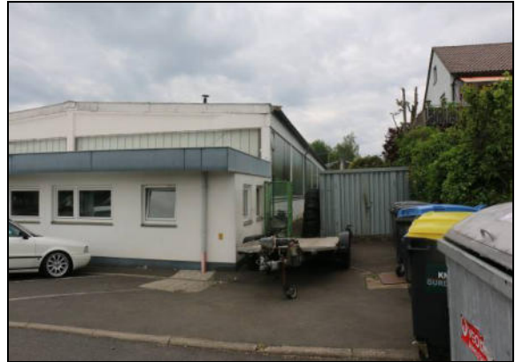
Abb. 3: Ansicht vom Landweg nach Westen
