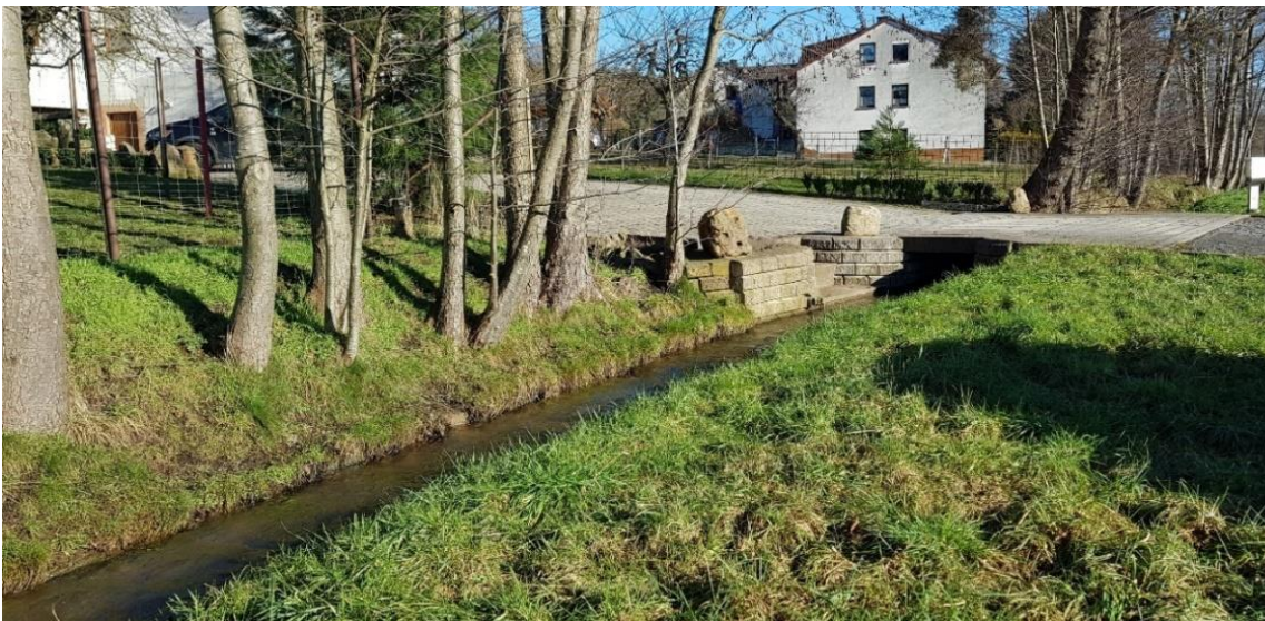
Abbildung 21: Mühlbach gegenüber Plangebiet, teilweise mit Zufahrten überbaut
