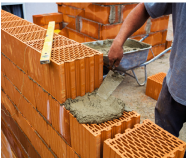
Mauerwerk aus Hochlochziegel
