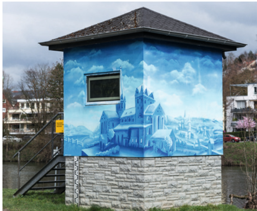
Pegelhaus an der Ruhr
