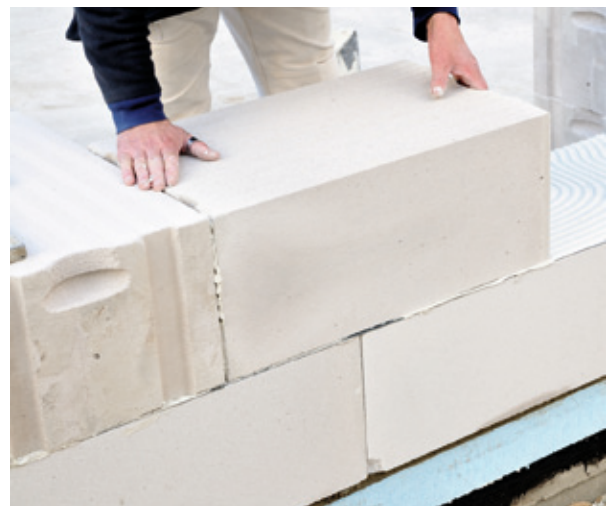
Mauerwerk aus Porenbeton-Plansteinen
