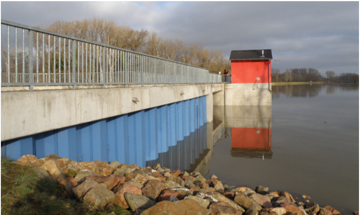
Polderflutung am Rhein bei Ingelheim
