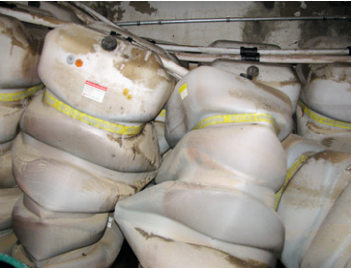
Zerstörte Heizöltanks infolge einer Hochwassereinwirkung
