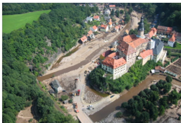
Hochwasserschäden 2002 in Weesenstein an der Müglitz ...
