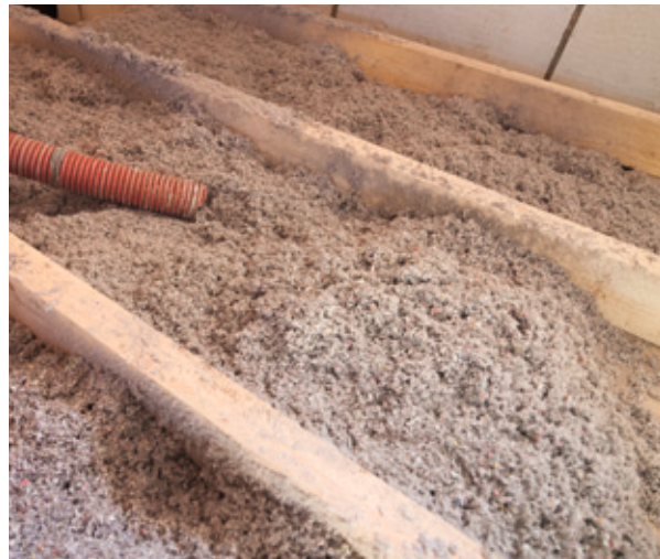
Anwendung von Zelluloseflocken im Fußbodenbereich
