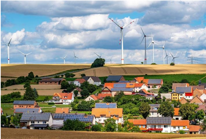
Photovoltaik im privaten Wohnbau
