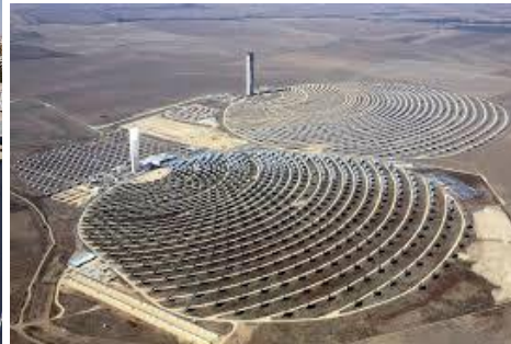
Solarwärmekraftwerk PS10 + PS20 Quelle: Wikipedia
