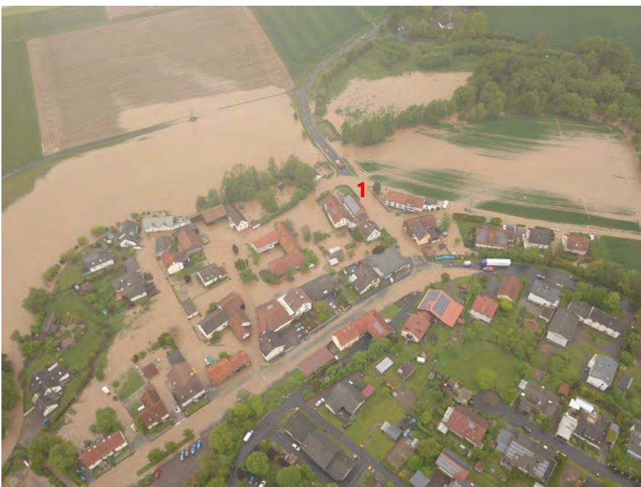
Anlage 21: Drohnenbefliegung in Melzdorf, Hochwasser 21.05.2019
